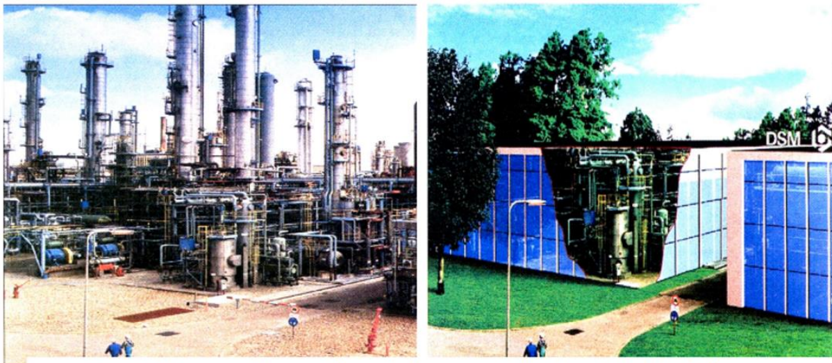
Procédé conventionnel (gauche) vs procédé intensifié (droite) (source DSM)
